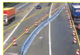
Barrera de acero VARIOGUARD galvanizada para desvíos definitivos o separación de carriles o calzadas. HOMOLOGADA para contención de vehículos H2 de la norma EN 1317 - 2.
