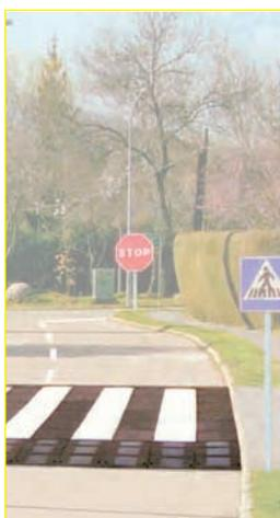
Sin necesidad de hacer obra, solo con tornillos, ensamblando elementos cuadrados de caucho de 50 x 50 cm, con rampas de 60 cm de longitud también de caucho.
