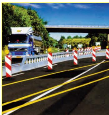
Las barreras de seguridad son un sistema de contención deformable y se puede utilizar tanto para obras definitivas como provisionales.
