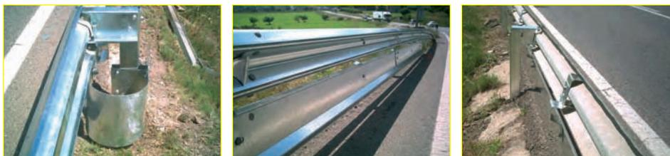
**PRETILES METÁLICOS DE CONTENCIÓN (PMC)**
