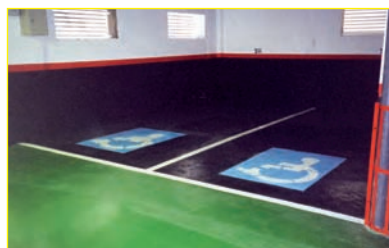
Aplicación de pinturas de poliuretano sobre pavimentos de hormigón.
