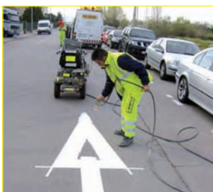
> Aplicación con máquina de tacos con pintura caliente.
