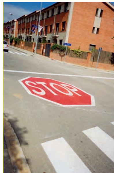
Aplicación de pintura dos componentes.
