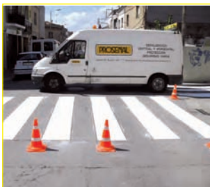
> Aplicación de pintura acrílica.
