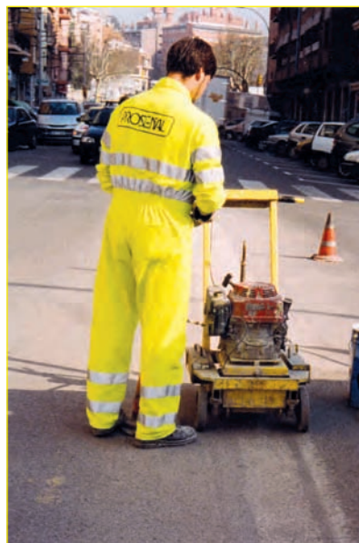
Eliminación de marcas viales mediante máquina fresadora.
